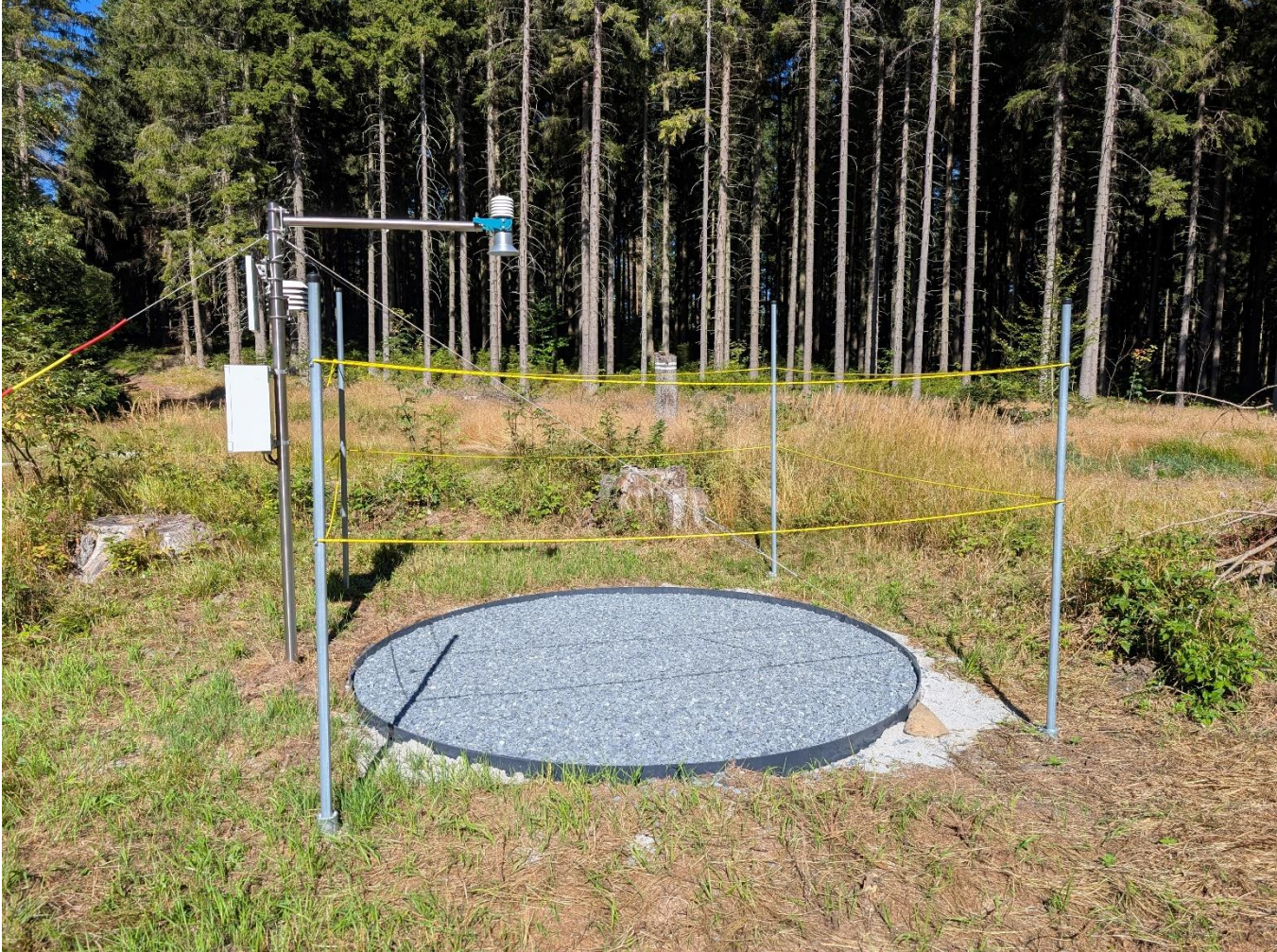
Automatická sněhoměrná stanice s měřením výšky sněhové pokrývky a vodní hodnoty v lokalitě Hubertka (Jeseníky), září 2025, foto: A. Kamínková
