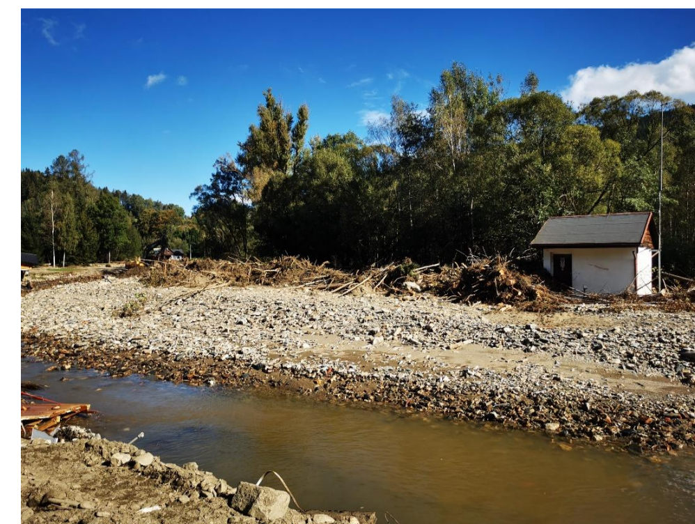
Vodoměrná stanice Mnichov (Černá Opava) po povodni, původní koryto za stanicí, foto ČHMÚ
